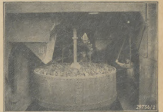
Abb. 6: Einfüllen des Erzes aus dem Bunker in den Kibel
