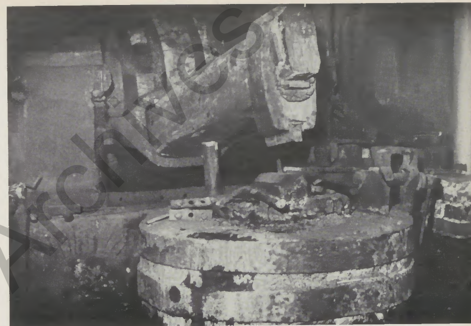
„Die Schmiede saßen ursprünglich auf dem Berg. Das änderte sich in der 2. Hälfte des 15. Jahrhunderts. Aus dieser Zeit hören wir zum erstenmal von einer Nutzbarmachung der Wasserkraft. Nun drehte das kreisende Rad an den Wasserhämmern den mächtigen Stamm der Rieseneiche, deren „Däuer“ wiederum die schweren Hämmer hoben und senkten.“ Alter Wasserhammer aus dem Morsbachtal.
