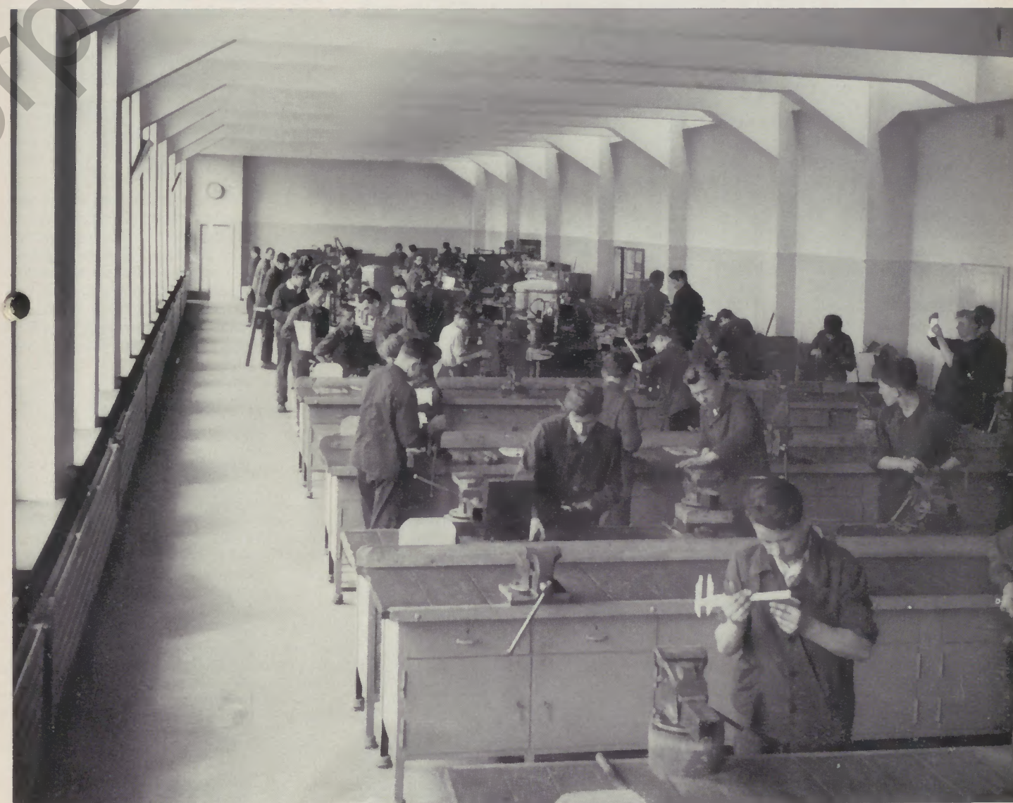
Die neue Lehrwerkstatt in Werk II ist licht und geräumig.
