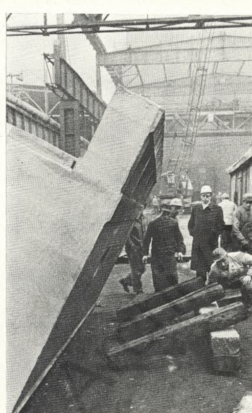
Stahlseile werden angelegt. Schließlich wird der Ständer so aufgerichtet, wie er später auf seinem Fundament stehen muß
