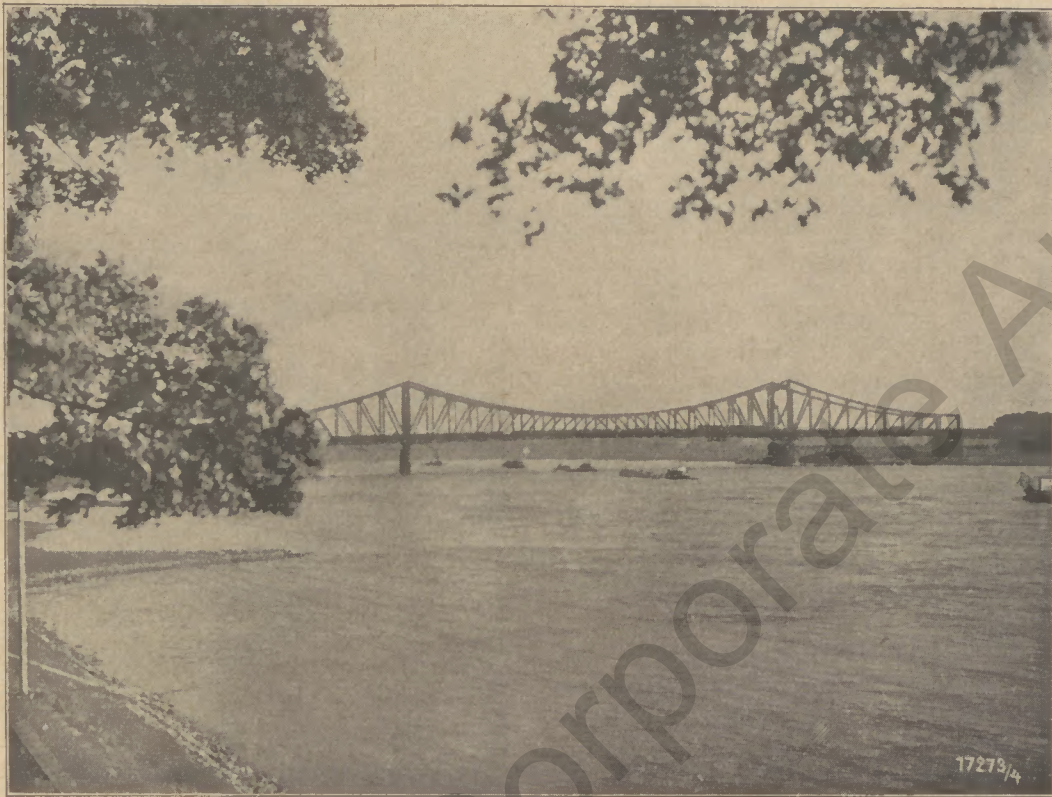
Die neue Rhein-Großbrücke der Dortmunder Union bei Düsseldorf-Neuß
