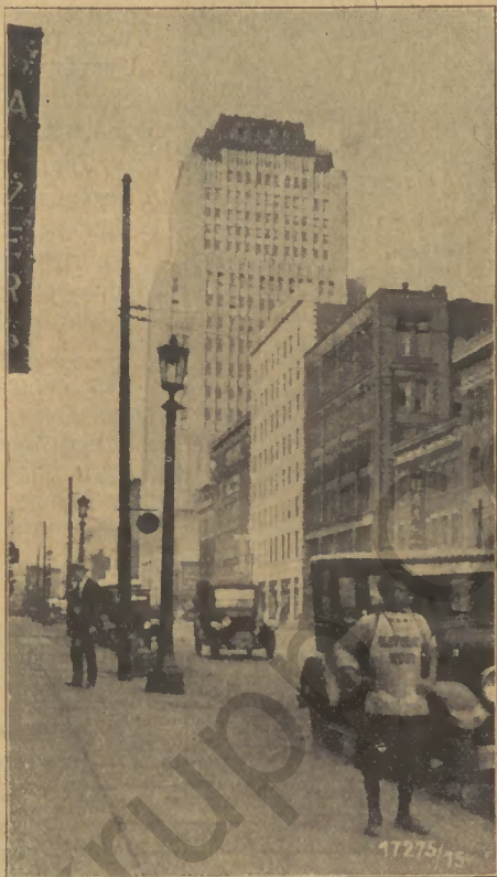
Gebäude der Bell-Telephone-Gesellschaft in Cleveland
