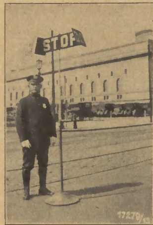
Stadthalle mit Saal für 15 000 Personen in Cleveland
