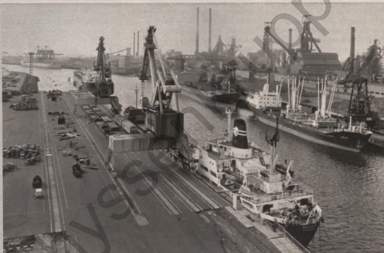
Vor den Hochöfen 1 bis 5 liegt der älteste Hafenteil von Hoogovens, in dem heute die kleineren Schiffe festmachen (im Hintergrund). Vorn der Außenhafen 3, in dem der Hauptteil der für den Export bestimmten Hoogovens-Erzeugnisse von zwei Portalkranen verladen wird
