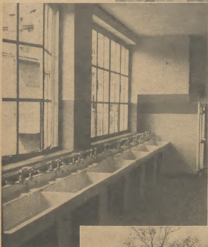
Teil des Waschraumes der Firma Bauer & Schaurte in Neuh
