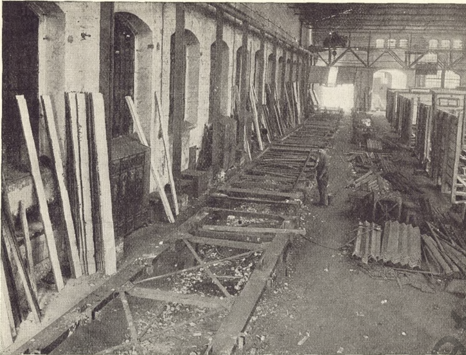
Serienbau von Seitenwänden im Austauschverfahren Union
