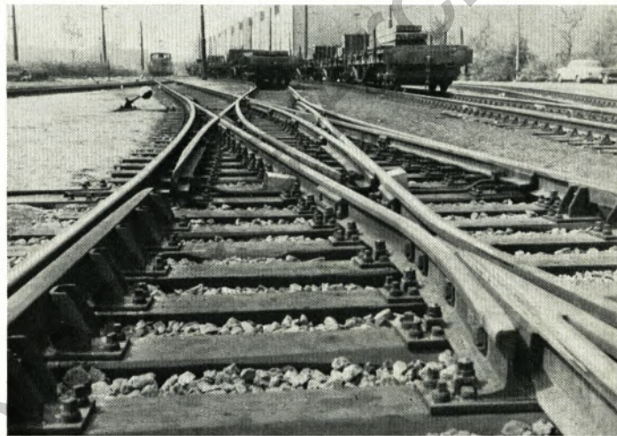
Eine doppelte Kreuzungsweiche 140 – 1 : 7, die ebenfalls unter Verwendung von Schienen UIC 60 hergestellt wurde.
