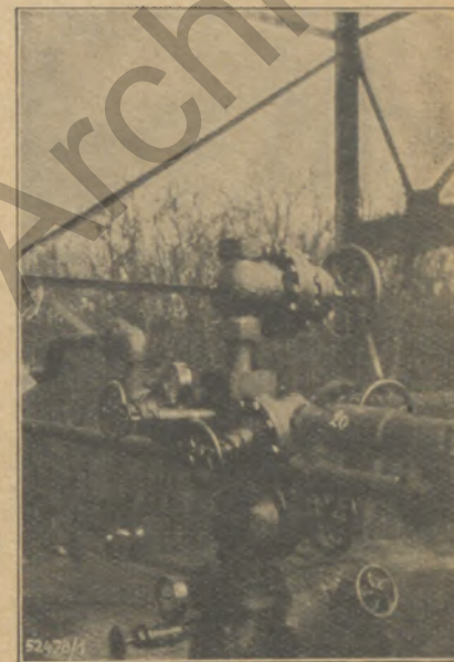
Bild 4: Eruptions-Sicherung, mit der Öl- und Gasaustritt bei den Erdölsonden reguliert wird
