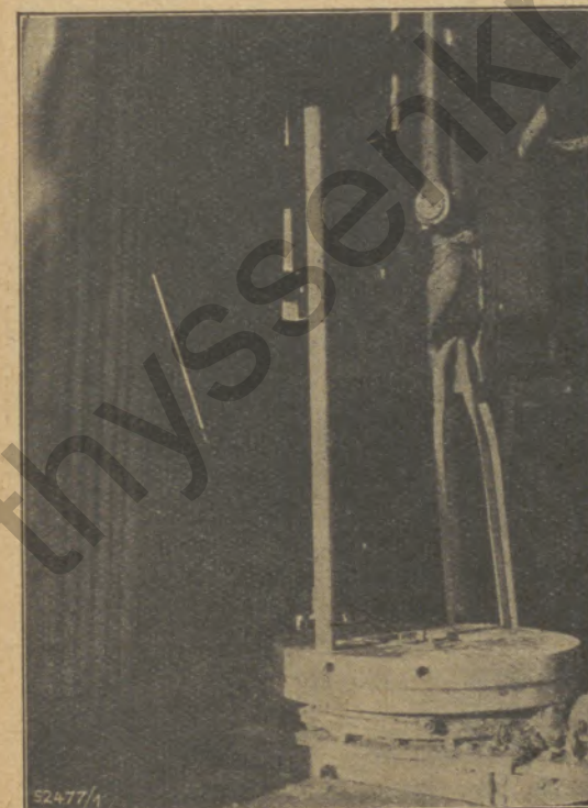
Bild 3: Der Stolz des Bohrermeisters: Drei Meter langer Kern aus einer Bohrung bei Mülhhausen. Das Bild zeigt außerdem den Drehstuhl, den Bohrhaken und links das abgestellte Gestänge
