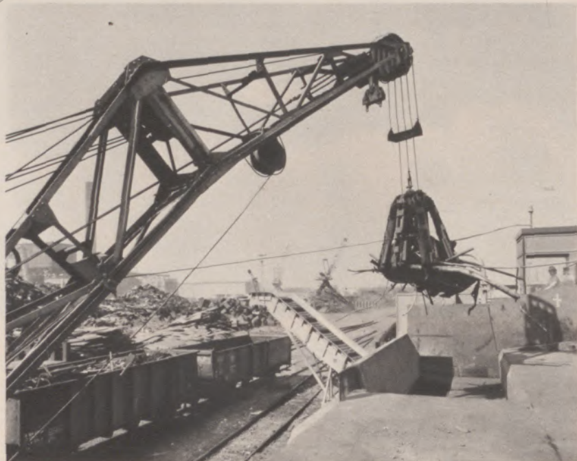
▲ Die Schrottverwertung Celler GmbH hat im Dortmunder Kohlehafen eine Schrottschere installiert, die Grobschrott auf Ofenlänge schneidet
