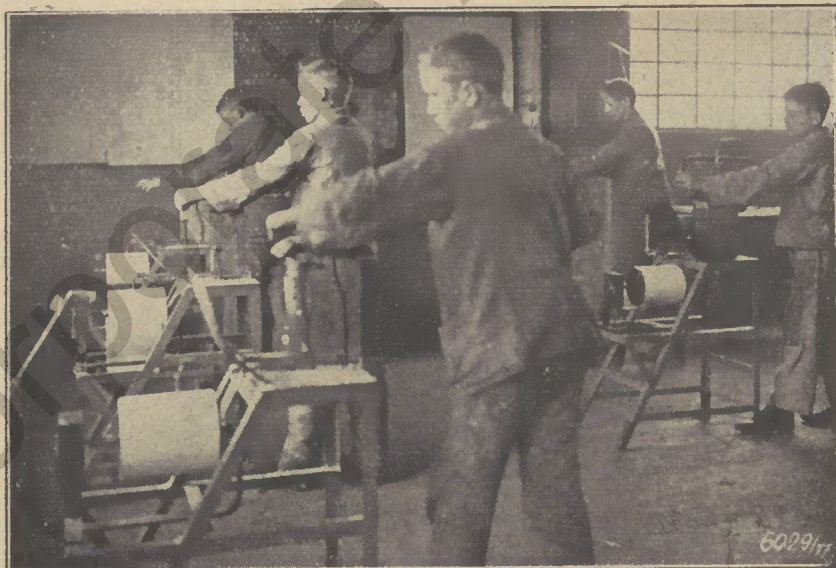
Übungsstand für Feilen und Sägen Die Geräte sind in einem besonderen Raum, dem sogenannten Übungsraum zusammen aufgestellt. Jeden Tag übt hier der Lehrling in den ersten Monaten der Lehrzeit für 1-2 Stunden die einzelnen Fertigkeiten, bis er die Handhabung seiner Werkzeuge gründlich beherrscht
