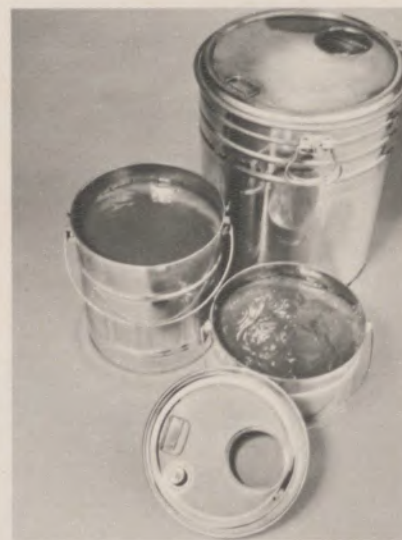
▲ Neuartige Zweikomponentenverpackungen für Lacke/Härter und Farben: Der Deckel ist zugleich Behälter des Zusatzstoffes
