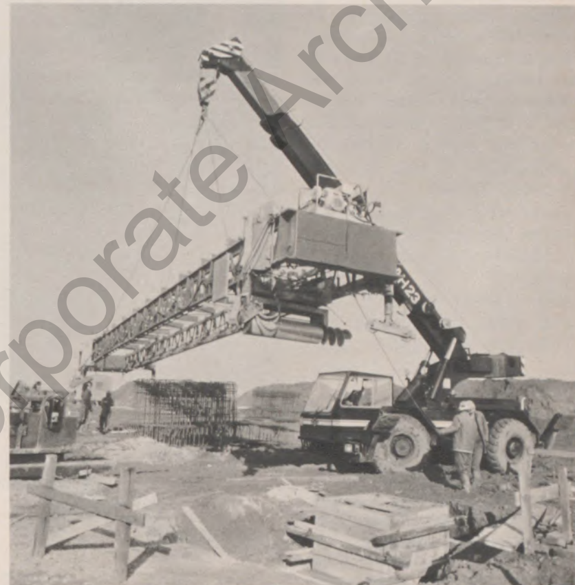
▼ Die Allrad-Hydraulikkranen von O & K Orenstein & Koppel können bis zu 21 Tonnen heben
