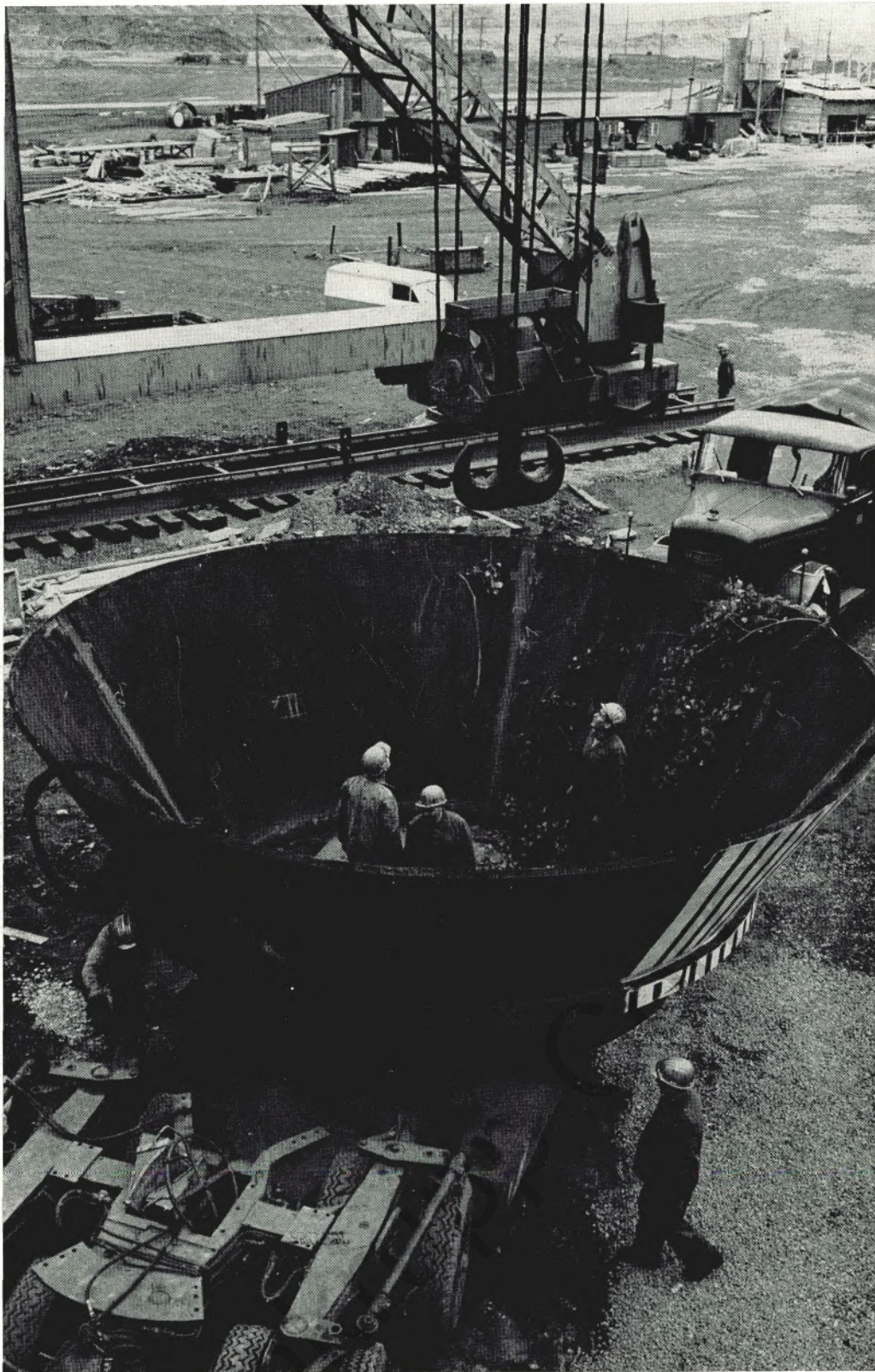
DREI MANN IN EINER GROSSEN WANNE: Die Haube eines Konverters für das in Bau befindliche Blasstahlwerk in Beeckerwerth ist eingetroffen (siehe hierzu die Berichte in dieser Ausgabe)
