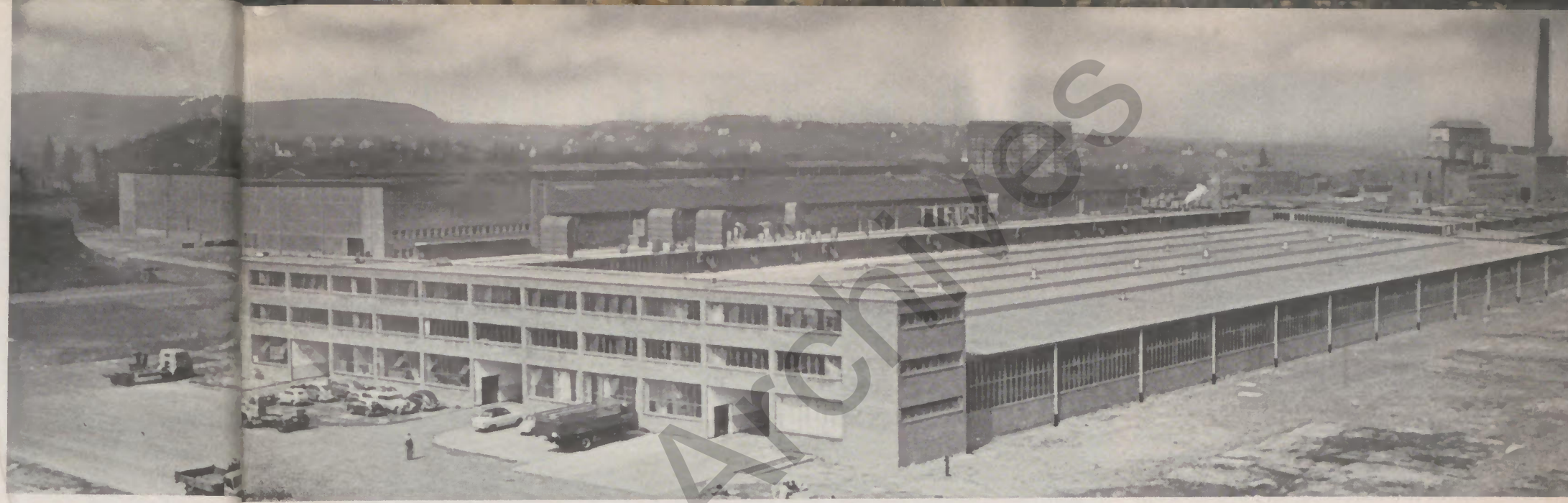
Der Henschel - Kraftwagenbau seiner heutigen Anlage. Die weiträumigen modernen Werkshallen, mit einer Ausdehnung von 46 570 qm, sind ein sehr imposantes Bild aus der Vogelperspektive.
