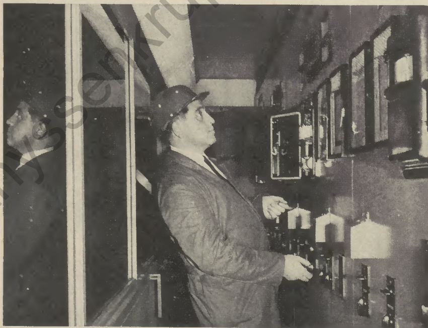
Das Gas-Luft-Gemisch zur Beheizung der Tieföfen im Walzwerk muß sehr genau eingestellt werden. Nach genauer Eichung der Geräte läuft die Verbrennung vollautomatisch ab.
