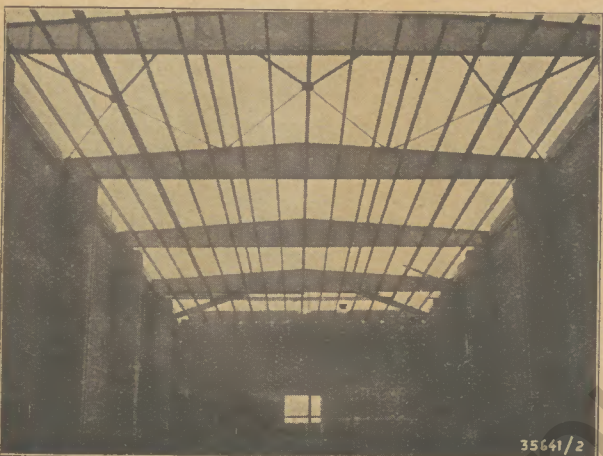
Lichtbogengeschweißte Dachkonstruktion einer Bahnhofsempfangshalle
