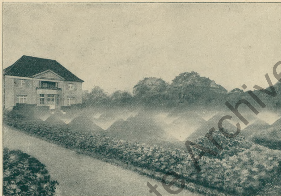
Abb. 4. „Phoenix“-Regenanlage (für Parks und Rasenspielfläche). Die Leitungen und Düsen liegen unterirdisch.
