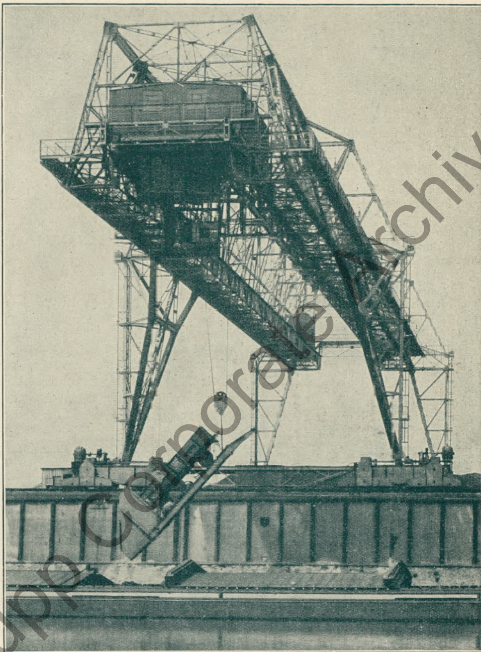
Verladebrücke der August Thyssen-Hütte im Hafen Schmelgraben.
