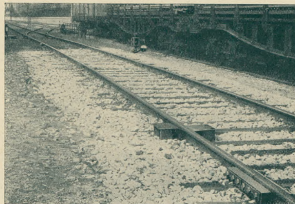
Abb. 10. Automatische Fahrstraßenauflösung durch Schienenkontakt.
