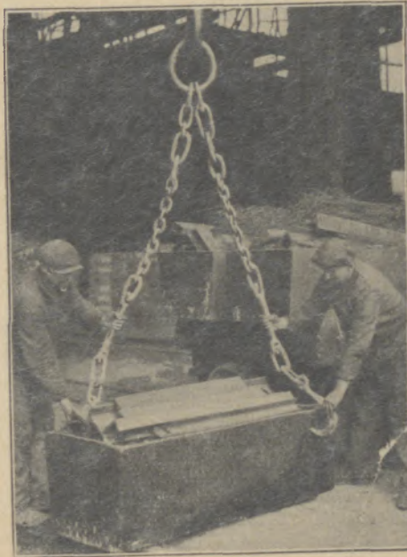
Abb. 8: Sicherungsglied an Ketten
