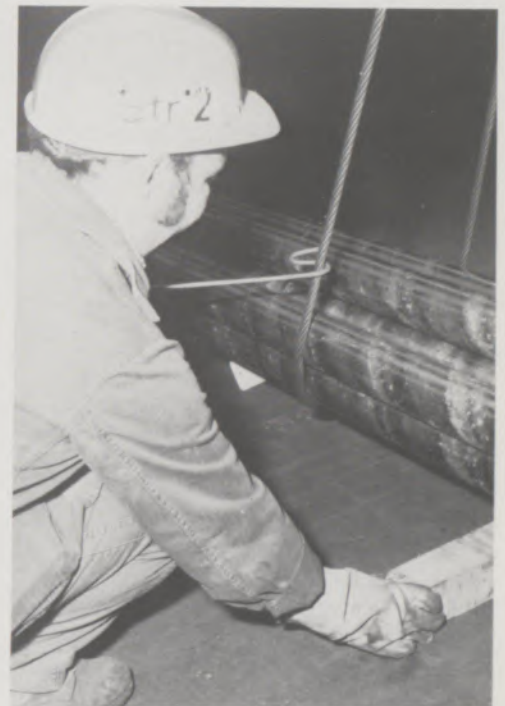
Bild 3: So ist es richtig! Niemals Finger zwischen Last und Unterlageholz bzw. Holz und Boden!
