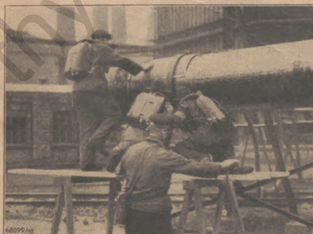
Der Störungsstrupp beim Flicken des Rohres
