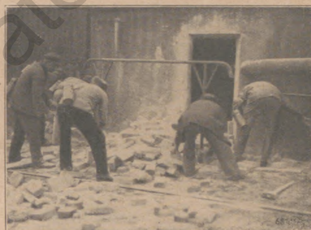
Der Wiederherstellungsstrupp hat den verschütteten Eingang freigelegt
