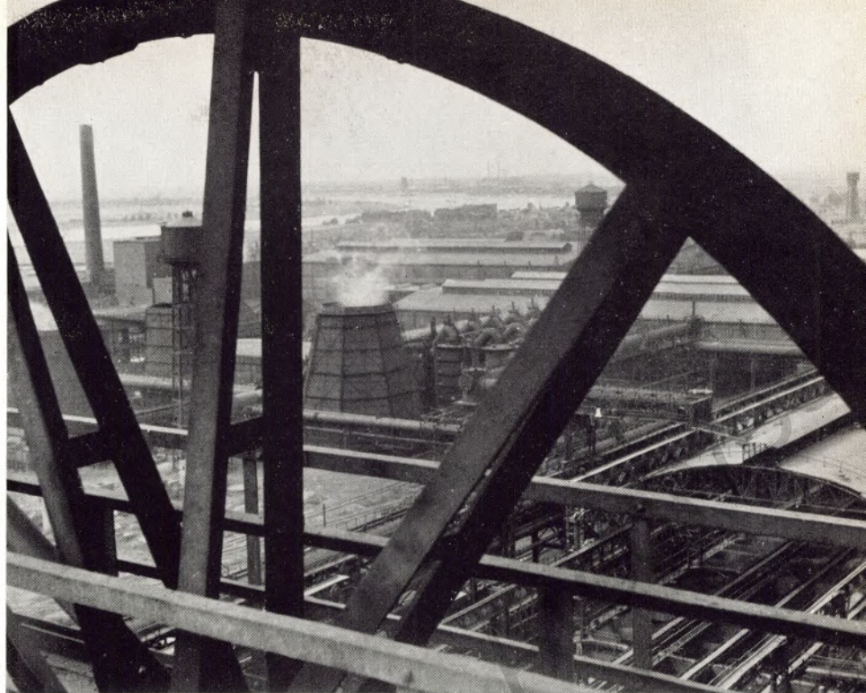
Schönheit der Technik: Blick von der Gicht des Hochofens 9 auf die Werksanlagen des Hüttenwerkes: Im Vordergrund die Gasreinigung, die Kraftzentrale und das Kesselhaus, im Hintergrund der Rhein mit der Einfahrt in den Hafen Schwelgern.
