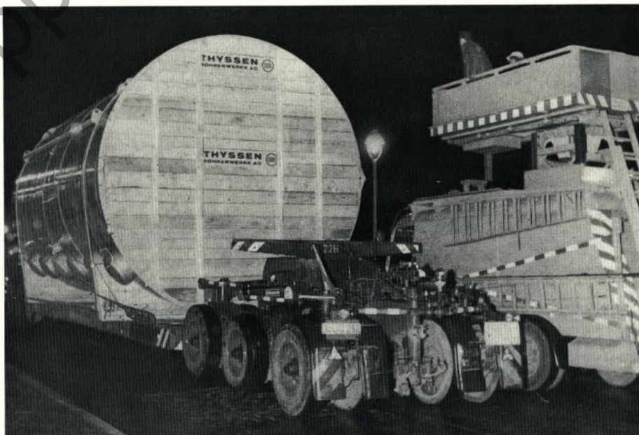
Einer der drei Teile einer Absorptionskolonne, die am 19. 4. nachts vom Werk Düsseldorf zum Hafen gefahren wurden. Die Teile der Kolonne, die für eine Salpeterfabrik in der Türkei bestimmt sind, wurden zunächst auf dem Schiffsweg nach Rotterdam gebracht. Der Transport vom Werk zum Hafen stellte die Organisationsgabe der Düsseldorfer Polizei auf eine harte Probe. Jeder Teil ist ca. 10 m lang, hat einen Durchmesser von 4,80 m, ist 5,60 m hoch und wiegt ca. 30 Tonnen.
