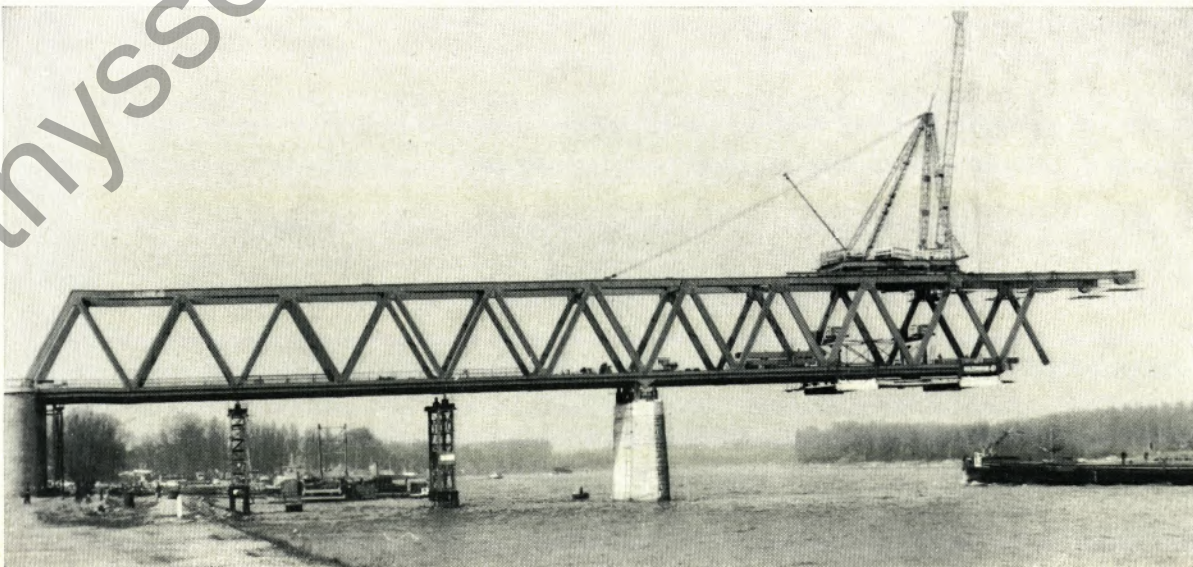
Die Fa. Aug. Klönne Dortmund montiert zur Zeit eine zweigleisige Eisenbahnbrücke über den Rhein bei Germersheim. Der Gesamtentwurf wurde von Klönne erstellt, während der Auftrag auf Lieferung und Montage von der Deutschen Bundesbahn je zur Hälfte auf Klönne und die MAN aufgeteilt wurde. Stahlgewicht 2140 t, Länge 268 m, Breite 9,50 m, Hauptträgerhöhe 10 m.
