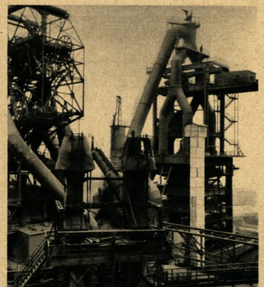
▲ Vierzehn Monate dauerte der Bau des neuen Großhochofens IV, dessen Rückansicht unser Bild zeigt. Er erzeugt täglich 1200 Tonnen Roheisen. Links der Hochofen III älterer Bauart
