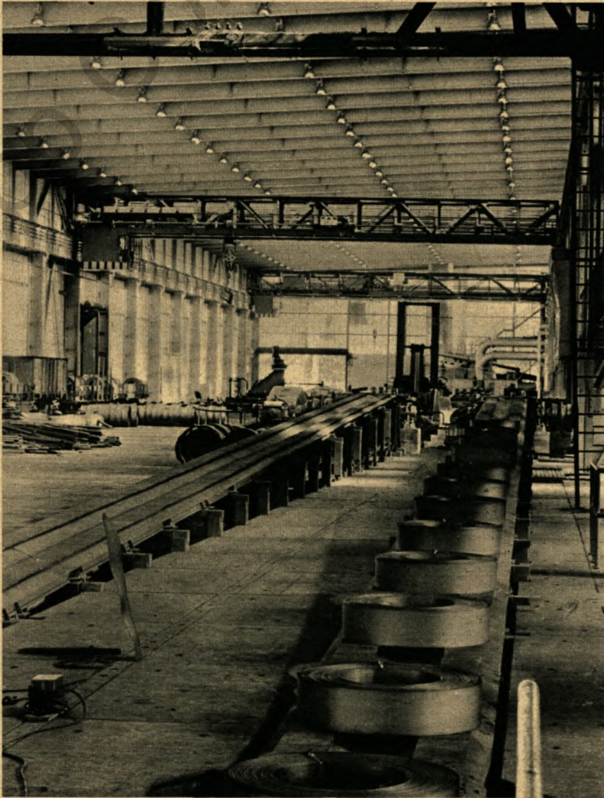
► Lagerhalle der vollkontinuierlichen Mittelbandstraße der Hoesch Walzwerke AG in Hohenlimburg. Haben die Bandringe das Ende des Warmbettes erreicht, werden sie plombiert, gewogen und zum Versand fertiggemacht
