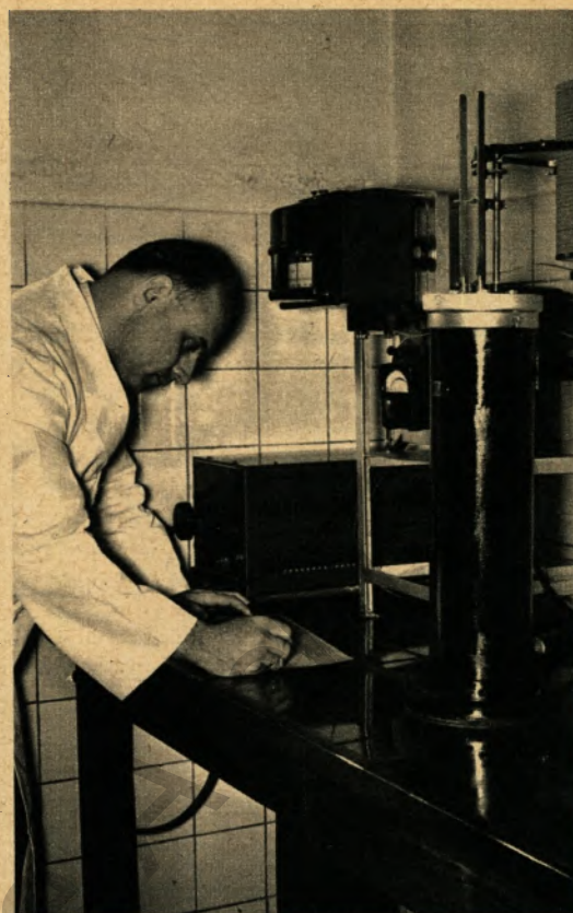
▲ Die Koksprobe wird auf ihre Verkokungseigenschaften hin untersucht. Laborant Werner Just überwacht die Dilatometer-Apparatur
