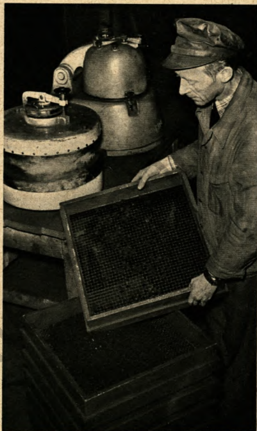
▲ Um den Wassergehalt der Kohle zu ermitteln, setzt Probenehmer Emil Trettmann die Kohleproben in den Ventilator-Trockenschrank ein
