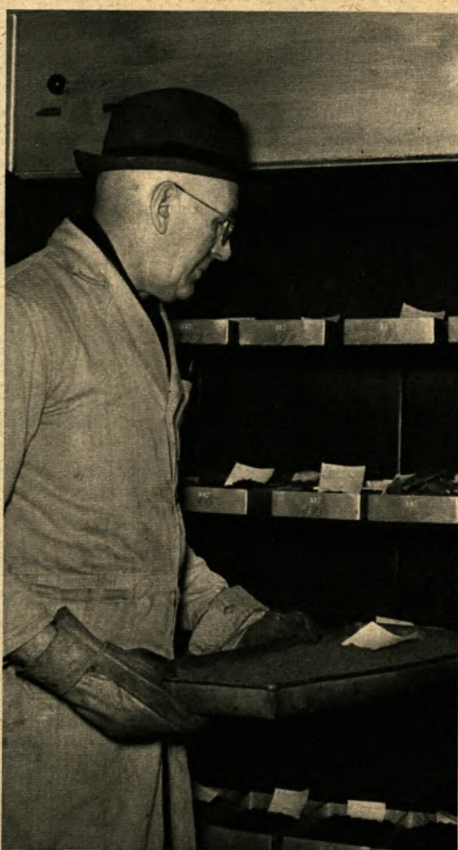
▲ Um den Wassergehalt der Kohle zu ermitteln, setzt Probenehmer Emil Trettmann die Kohleproben in den Ventilator-Trockenschrank ein
