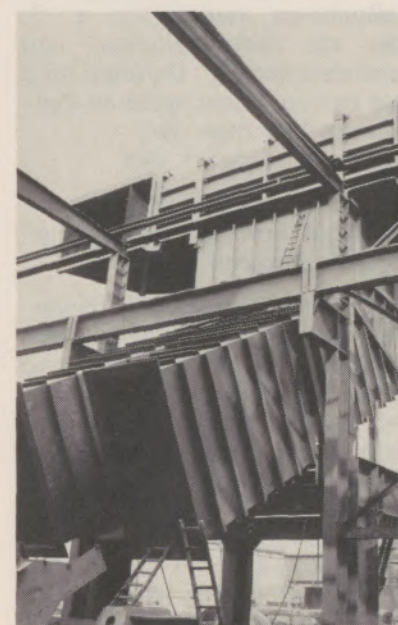
Montage der Reingasleitung hinter den Sinterabgasfiltern
