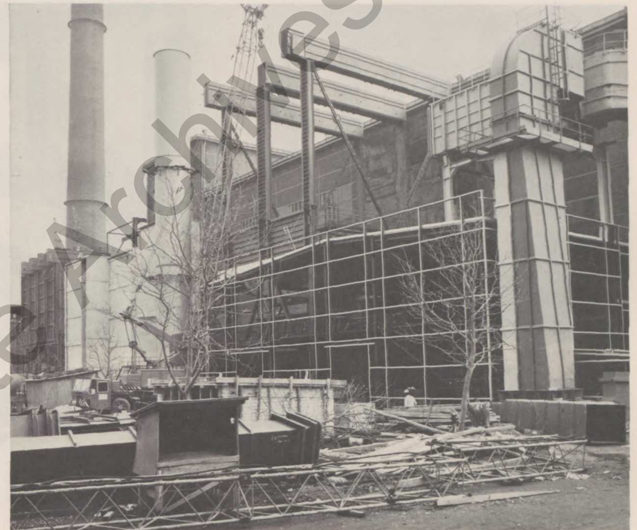
Montage der Reingasleitung hinter den Sinterabgasfiltern
