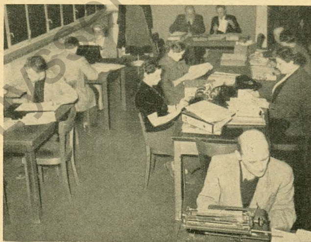
Teilansicht der Ufi bei der Arbeit
