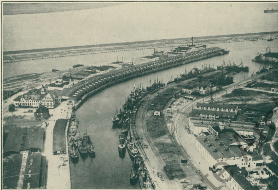
Altes Fischereihafen in Wesermünde. Lichtbild: Wasserbauamt Wesermünde
