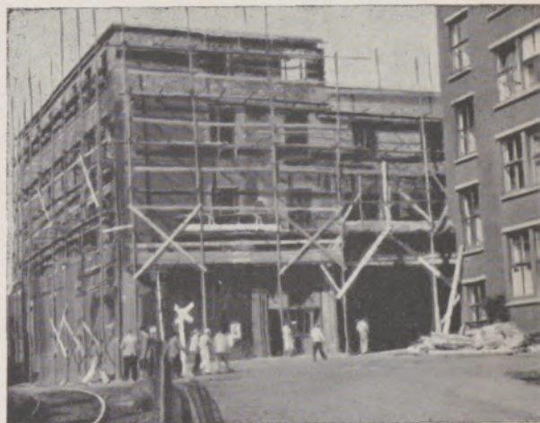
Der Neuaufbau des Wohlfahrtsgebäudes schreitet rüstig vorwärts. Ansicht vom Werkshof aus
