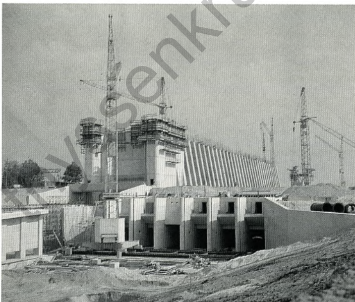
Gesamtansicht der Schleuse Uelzen. Im Vorderteil des Hochbaues befinden sich Seitenführungen und Dichtleisten für das Hubtor.
