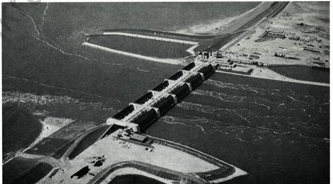
Zu den imponierenden Leistungen des Stahlwasserbaus zählt das Eidersperrwerk an der Nordseeküste, das mit fünf stählernen Doppelschützen von je vierzig Meter Breite das Land vor Wassernot bewahrt.
