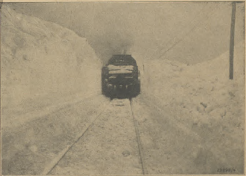
Die Schneesleuder hat eine fünf Meter hohe Schneewand durchstoßen
