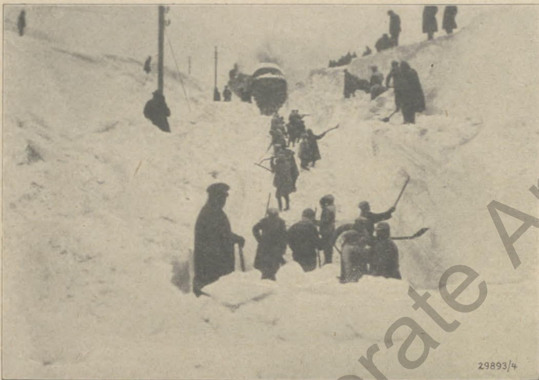
Bei sehr hoher Schneewand kann auch die Schneeschleuder nur stufenweise vordringen; in der Ruhestellung wird der Dampf wieder auf volle Spannung gebracht
