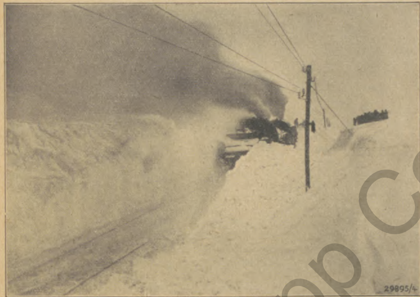
Schneesleuder im Angriff gegen eine hohe Gleisverwehung
