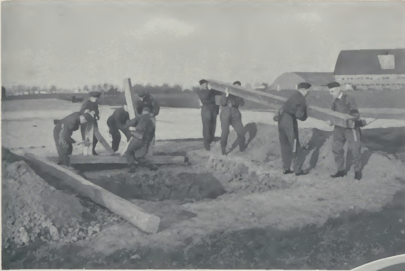
Bild links: Überbrücken eines Trichters durch den Wiederherstellungs- trupp
