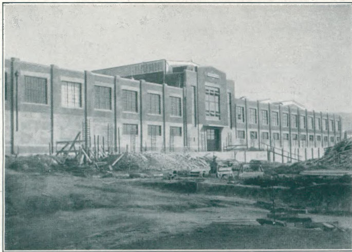
Rückansicht der Werkstat im Rohbau.
