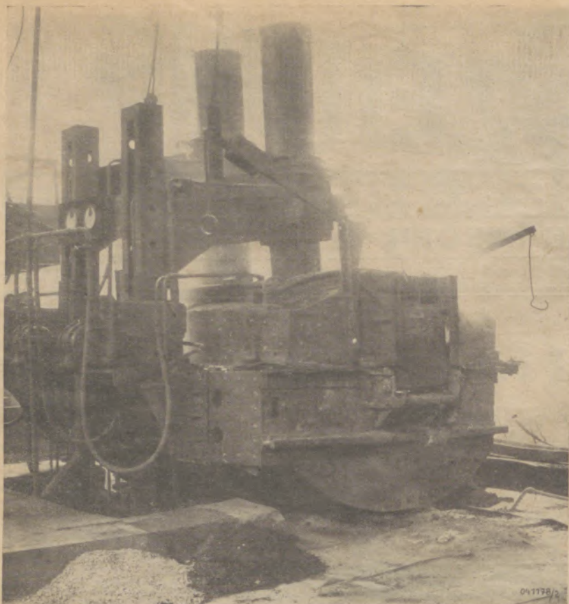
Wie dunkle Schiffsmasten ragen die Elektroden über das Deckengewölbe des Ofens hinaus
