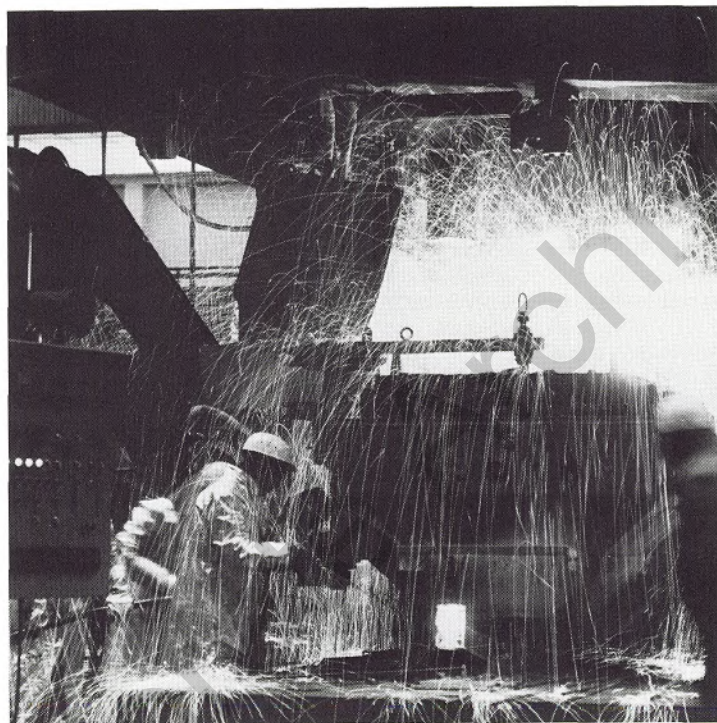
Eine der größten Investitionen der letzten Zeit überhaupt: die zweisträngige Brammen-Stranggießanlage im Werk Beckerwerth. Sie wurde am 14. November 1974 offiziell in Betrieb genommen.
