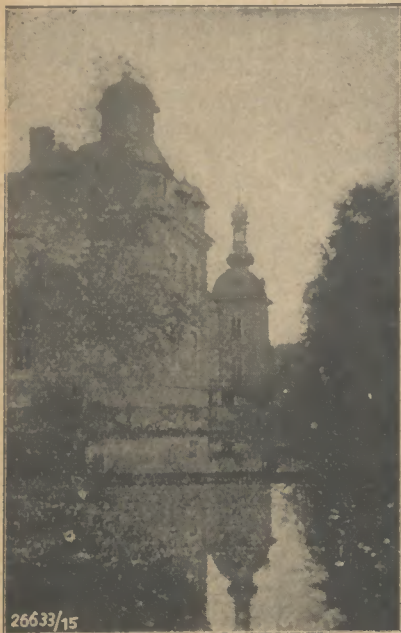
Bild 5: Schloss Velen: Westfront mit Wassergraben, Zugbrücke und fester Brücke
