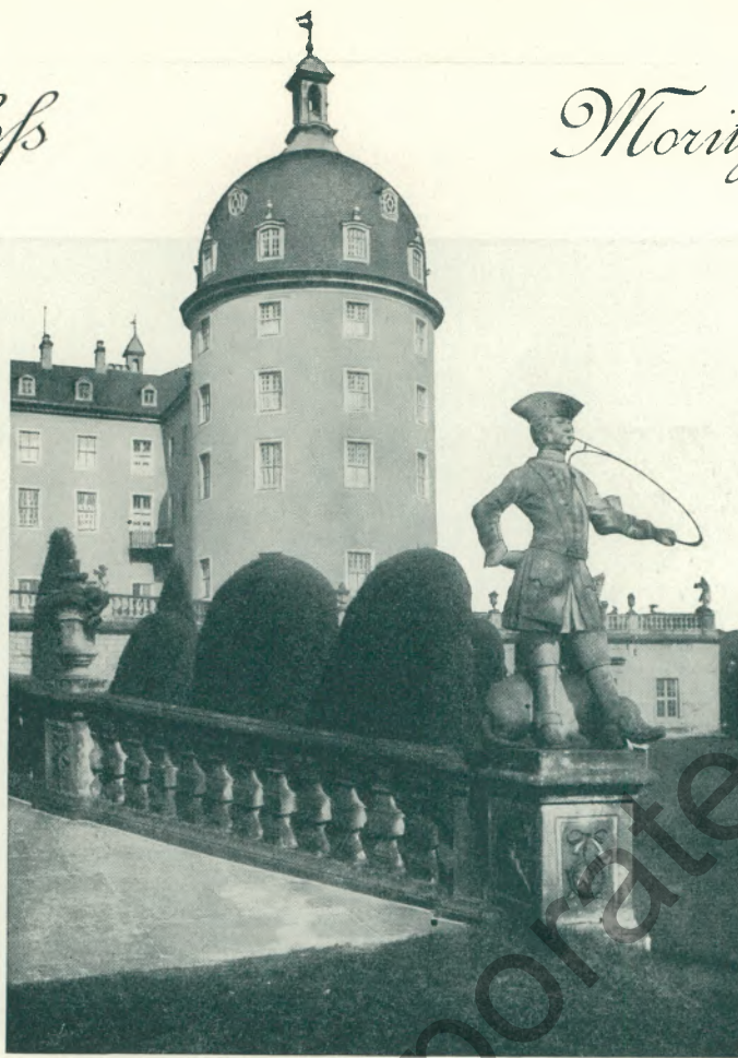
Eckturm des Jagdschlösses Moritzburg.
