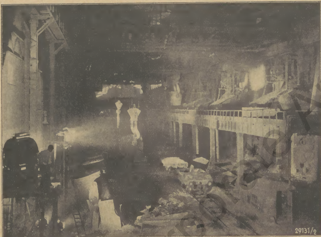
Filmaufnahme im Thomaßwerk der Vereinigte Stahlwerke Aktiengesellschaft, August Thysen-Hütte, Hamborn; links die großen Scheinwerfer
