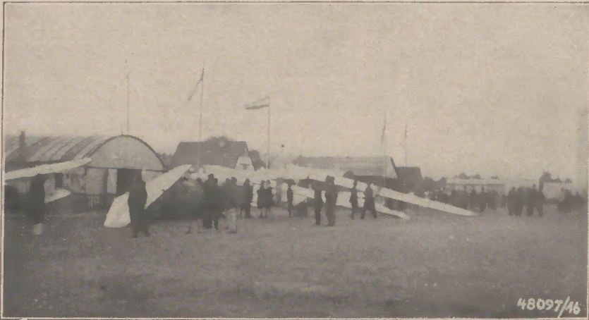
Vor den Flugzeughallen des Flugplatzes Borkenberge
