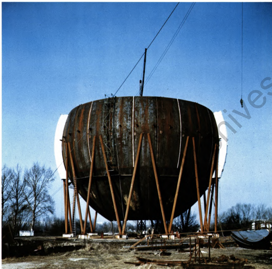
Stadtgaskugel : 29 Meter Durchmesser, 30 Millimeter Wanddicke.
