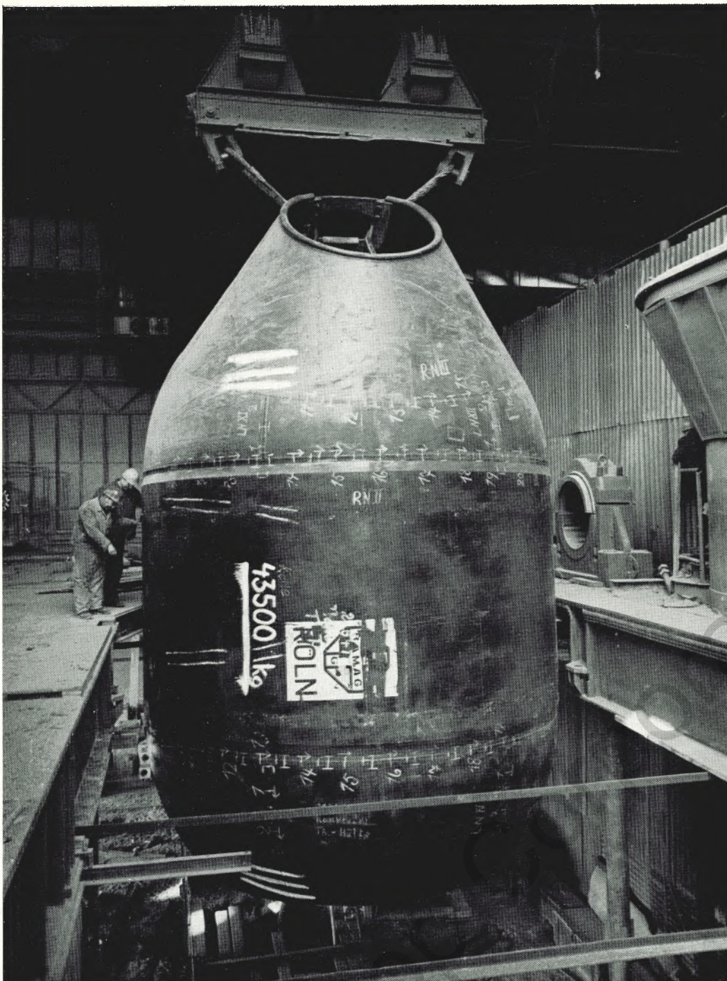
Es ist geschafft: Das neue Konvertergefäß wird im Thomaswerk zwischen die Ständer abgestellt
