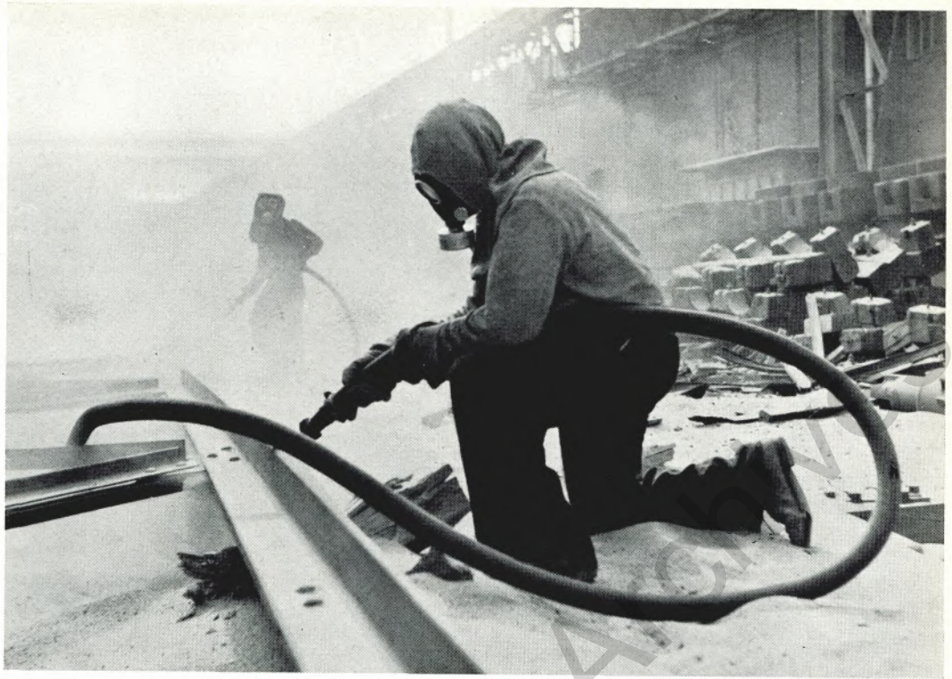
Bei Arbeiten mit dem Sandstrahlgebläse sind die vorgeschriebenen Schutzmasken zu tragen
