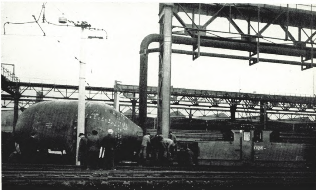
Verschieben der Last mit Hilfe eines Kettenzuges (oben) ließ die Engpässe an der Bandanlage und am Trägerlager (unten) überwinden
