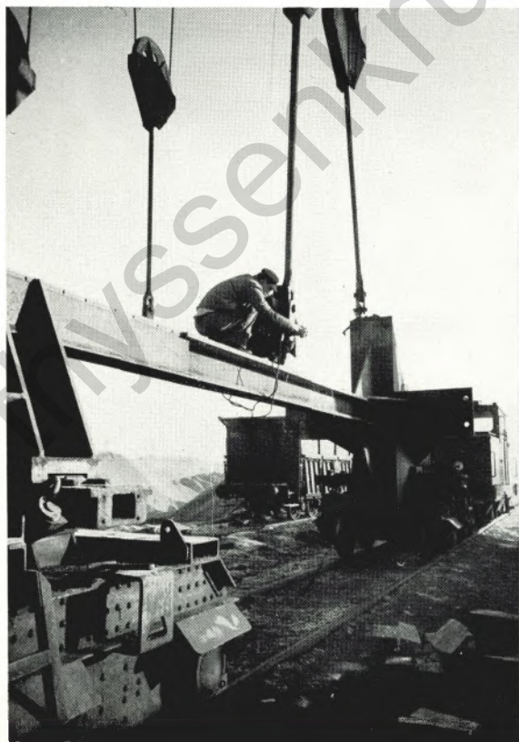
Die Verladebrücke 1 am Nordufer beginnt ihre Arbeit: Seile werden am Träger befestigt, der dann die Tragachse für das 43,5 Tonnen schwere Konvertergefäß bilden wird
