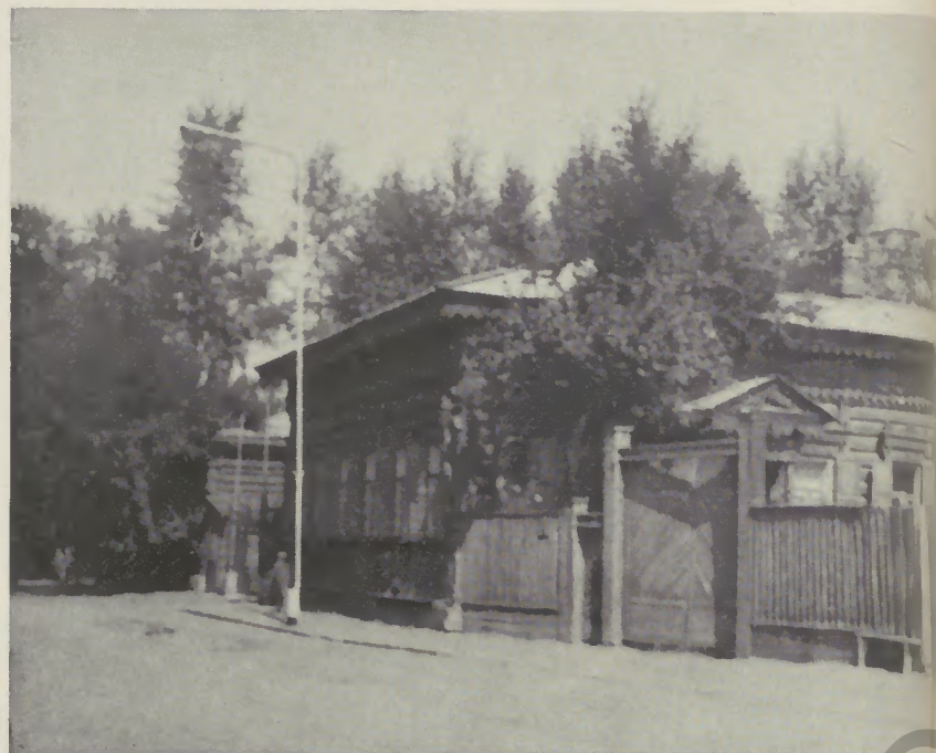
Altes sibirisches Holzhaus in Irkutsk. Heute werden nur noch mehrgeschossige Beton-Fertighäuser im Einheitsstil errichtet.
