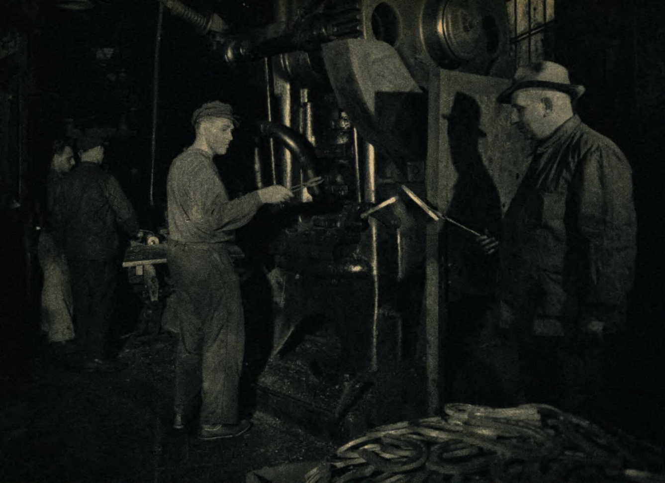
Im Hintergrund arbeiten Arthur Fuhl und Friedhelm Joraskiwitz an der Hufeisenbiegemaschine. Arnold Schulte legt die vorgeformten Eisen in die Presse ein, während der Vorarbeiter Friedrich Esser eine Stichprobe macht.
