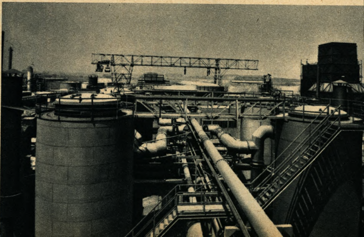
Ein Blick auf die noch im Ausbau befindlichen Anlagen vor dem Kriege
