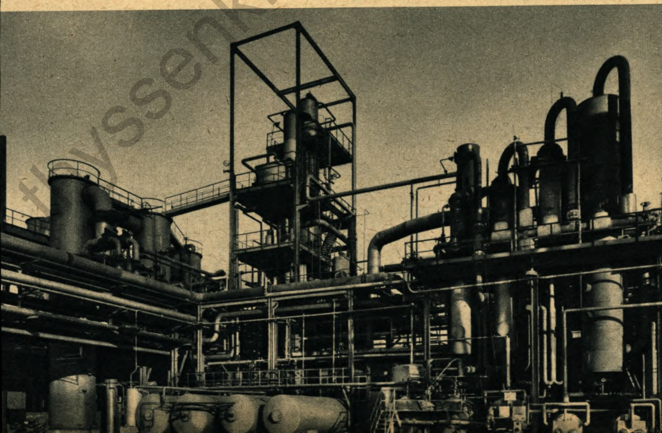
Rohrleitungen und Kessel in großer Zahl bestimmen das Gesicht einer solchen Mitteldruck-Synthesanlage, wie sie bei uns im Jahre 1937/39 errichtet wurde
