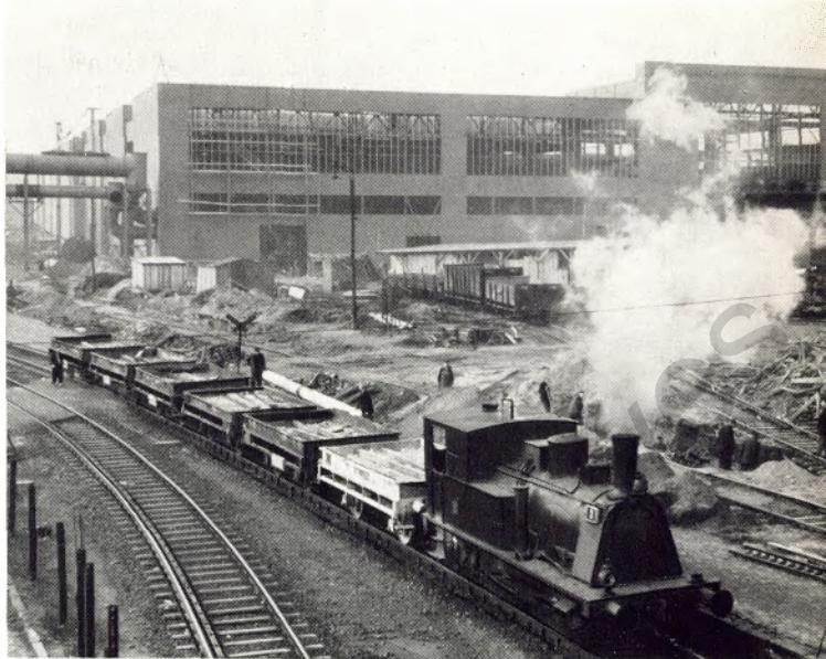
Um die Dezembermitte von der Thyssen-Brücke aus gesehen. Schon vollendet sich das Bild der Hallen, in denen die Breitbandstraße mit allen ihren Nebenanlagen steht. Aber noch ist ringsumher, wie das Bild veranschaulicht, Hochbetrieb auf dem Baugelände.
