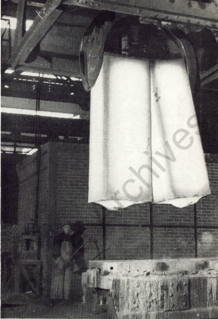
▲ Zwei rot- und weißglühende Blöcke von 6 t Gewicht hat hier der Kran in der Stripperhalle unseres Thomaswerkes in der Zange, um sie auf die Föhre abzusetzen.
