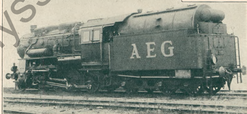
Die erste Kohlenstaublokomotive der Welt.
