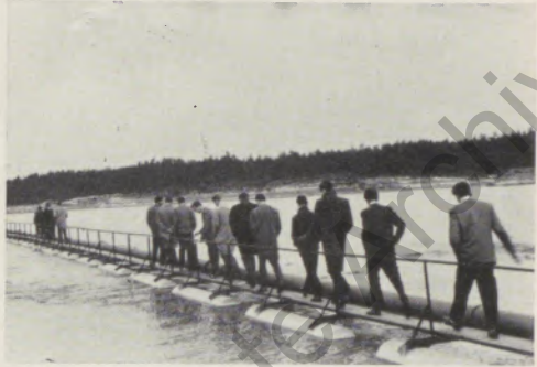
Rohrleitung mit Laufsteg
