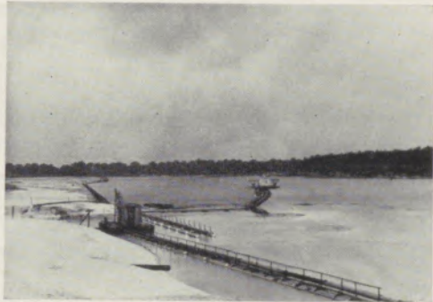
Sandgrube in Bildmitte - 2 Saugschiffe mit den schwimmenden Rohrleitungen
