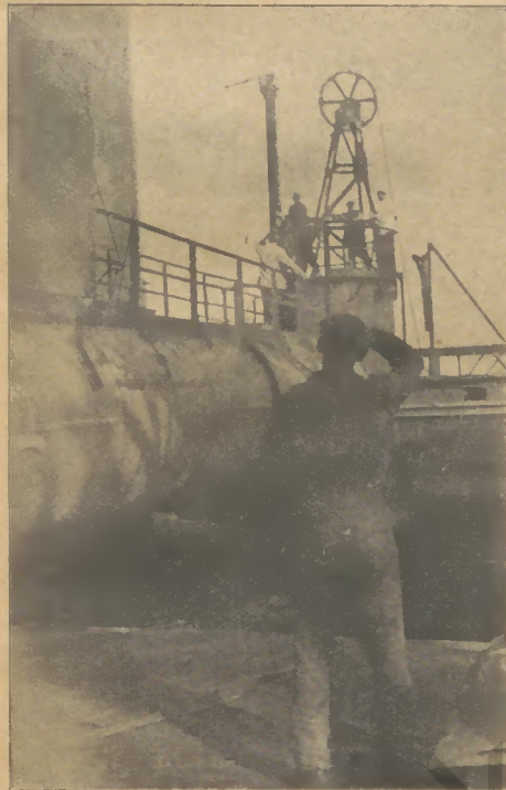
Bild 5: Absperrung der Gaszufuhr
