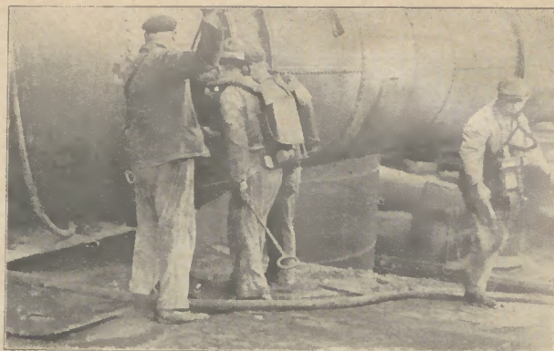
Bild 10: Abfragen der Ansätze der Reglerklappe Da Rückstoß aus der Leitung mit erhöhter Gaskonzentration möglich, arbeiten die unmittelbar an der Klappe tätigen Leute mit Träger-Apparaten, die Zureicher (Hilfsmannschaft) mit CO-Filtern
