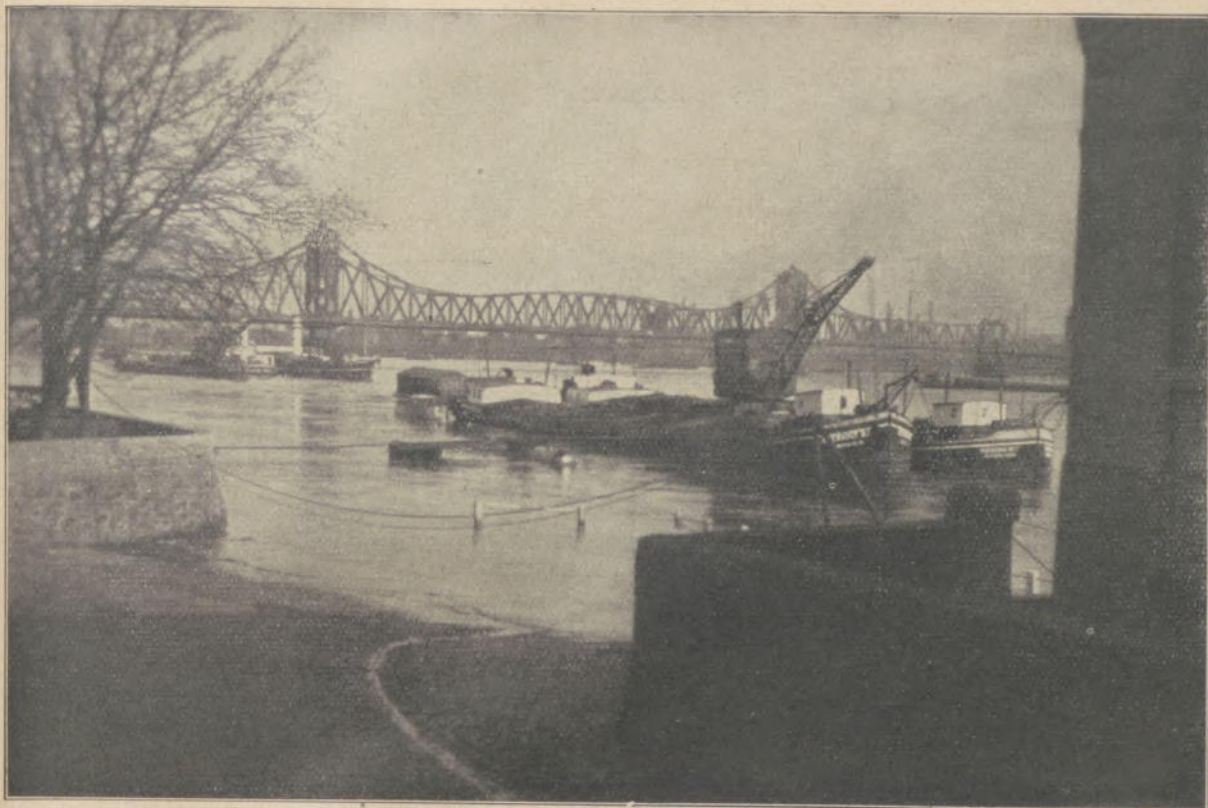
Hochwasser an der Ruhrorter Rheinbrücke / Aufnahme am 13. Oktober 1930 von E. Stein
