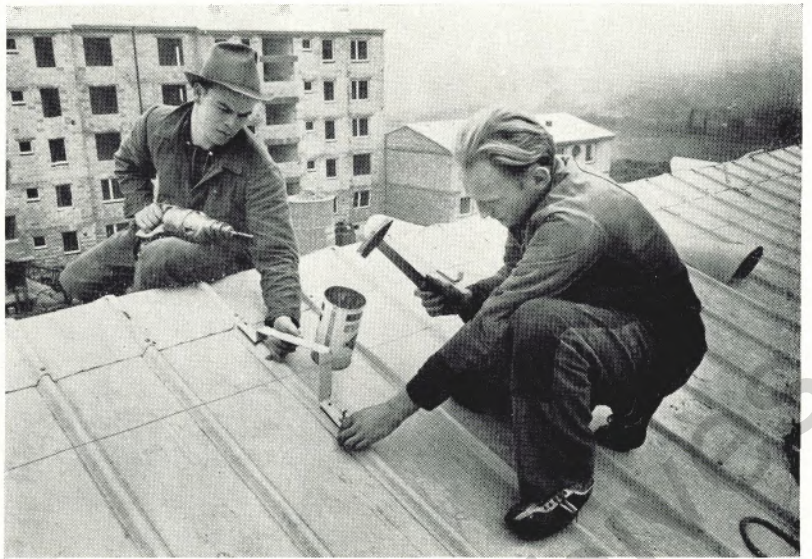
stattet auch bei geringerer Dachneigung leichtere Dachkonstruktionen. Auf dem Bilde rechts befestigen die Handwerker gerade Stützen für die Dach-Laufstege
