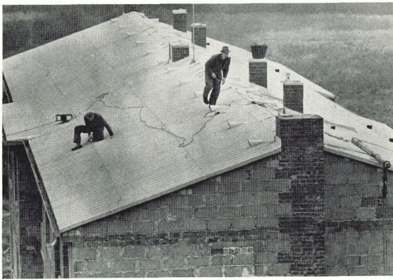
Geschmackvoll und zweckmäßig ist die Bedachung aus verzinkten Stahlblech-Dachpfannen. Das geringe Gewicht der Pfannen erlaubt eine leichte Montage und ge-
