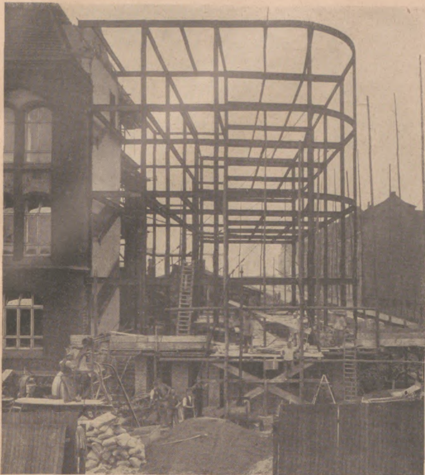
Abb. 6: Stahlstelett des Neubaus
