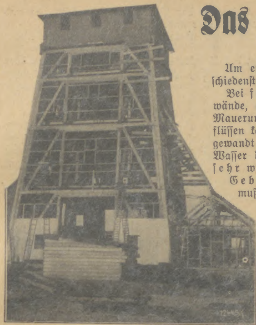
Abb. 1: Bohrturm im Bau
