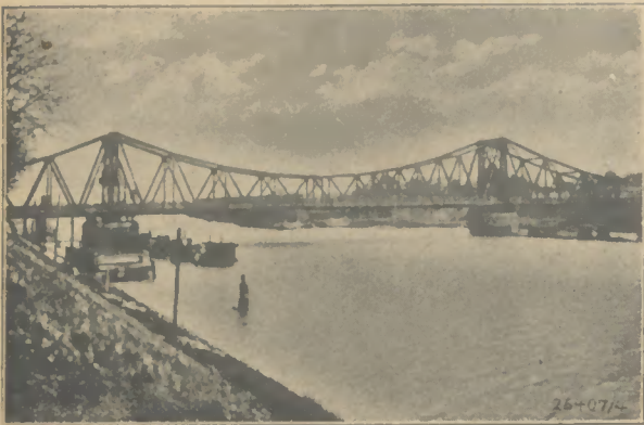
Strahndrehbrücke über den Kaiser-Wilhelm-Kanal bei Rendsburg
